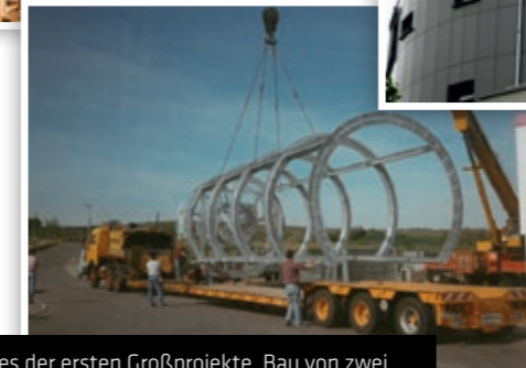
1995 Eines der ersten Großprojekte. Bau von zwei Treppentürmen als Stahlkorpus zur Einhausung von Treppenaufgängen.
